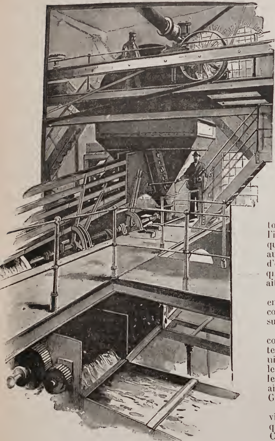
L'INDUSTRIE DE LA HOUILLE. Appareil à mouler les briquettes.
